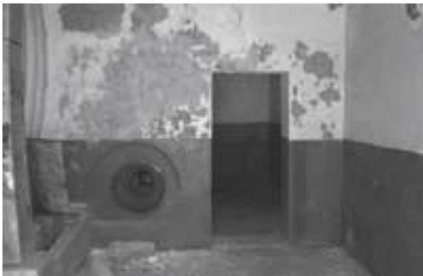
Главный зал, вентиляционная система
